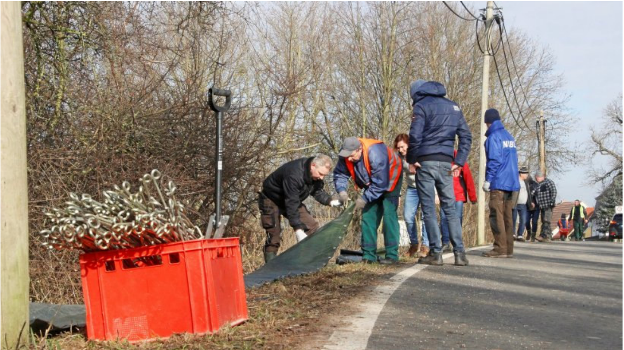
Viele Hände packten mit an beim Aufstellen des Schutzzauns am Sonnabend am Ortsteingang von Steinbrücken Foto: Marcel Hilbert
