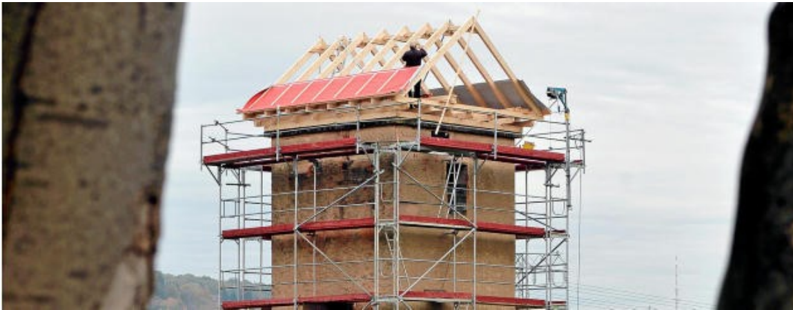
Der neue Artenschutzurm auf Bad Köstritzer Flur nimmt Formen an. Foto: Peter Michaelis
